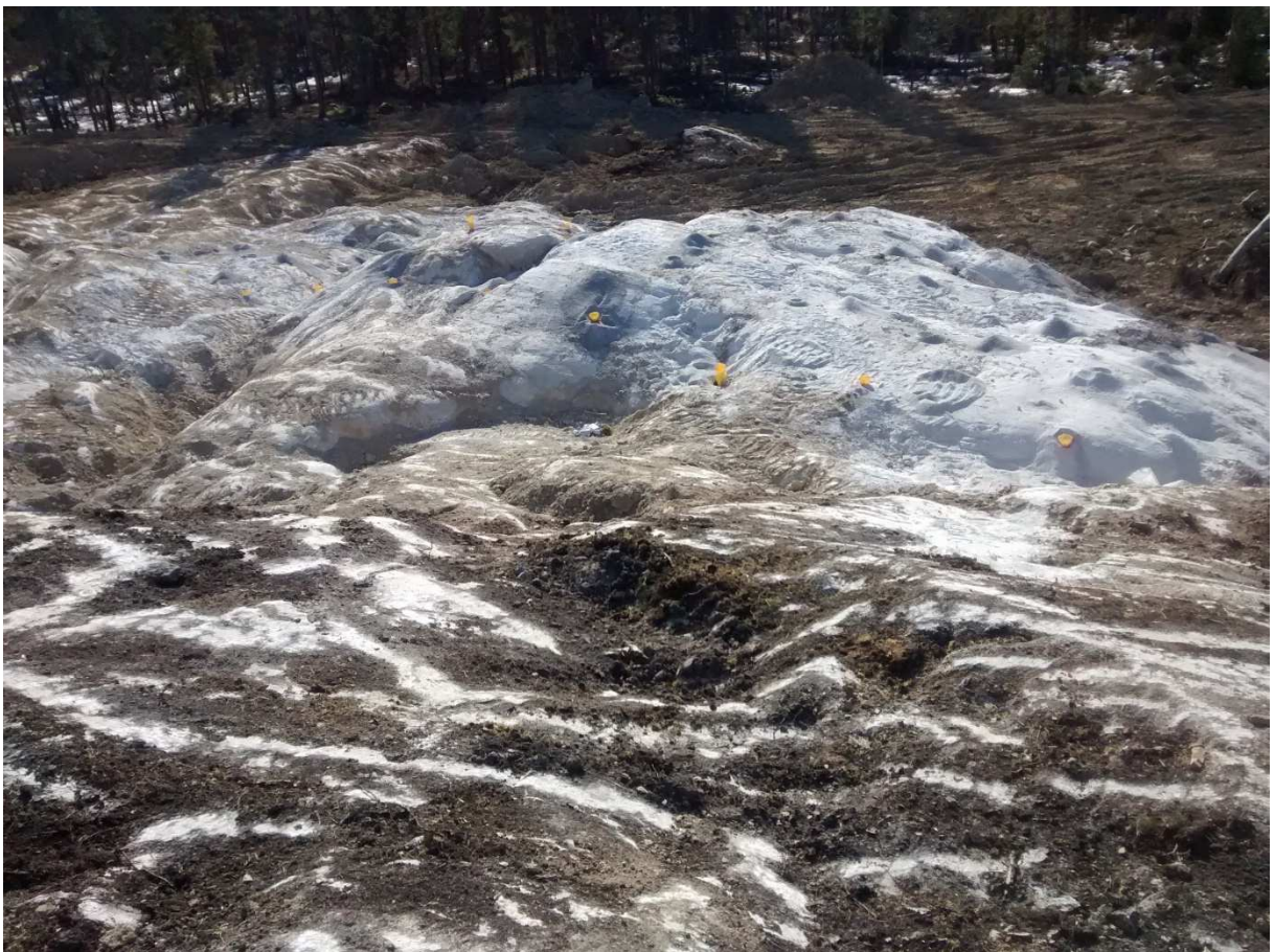
Borrning i berg och förberedelser för sprängning: sprängdubbar. Foto taget den 2018-04-02
