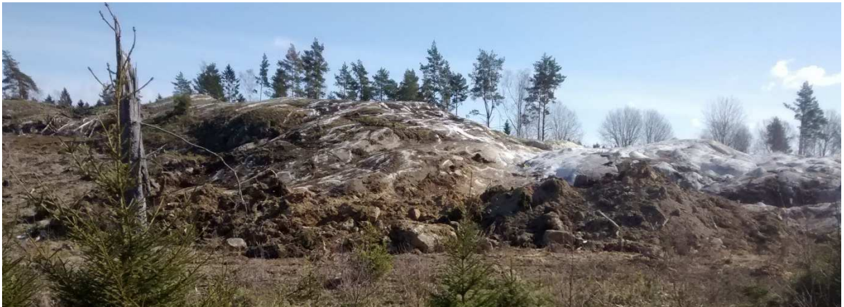
Hela berget har rensats. Borrning i berg och förberedelser för sprängning pågår i den högra delen (som är vit pga borrdamm). Foto taget den 2018-04-02
