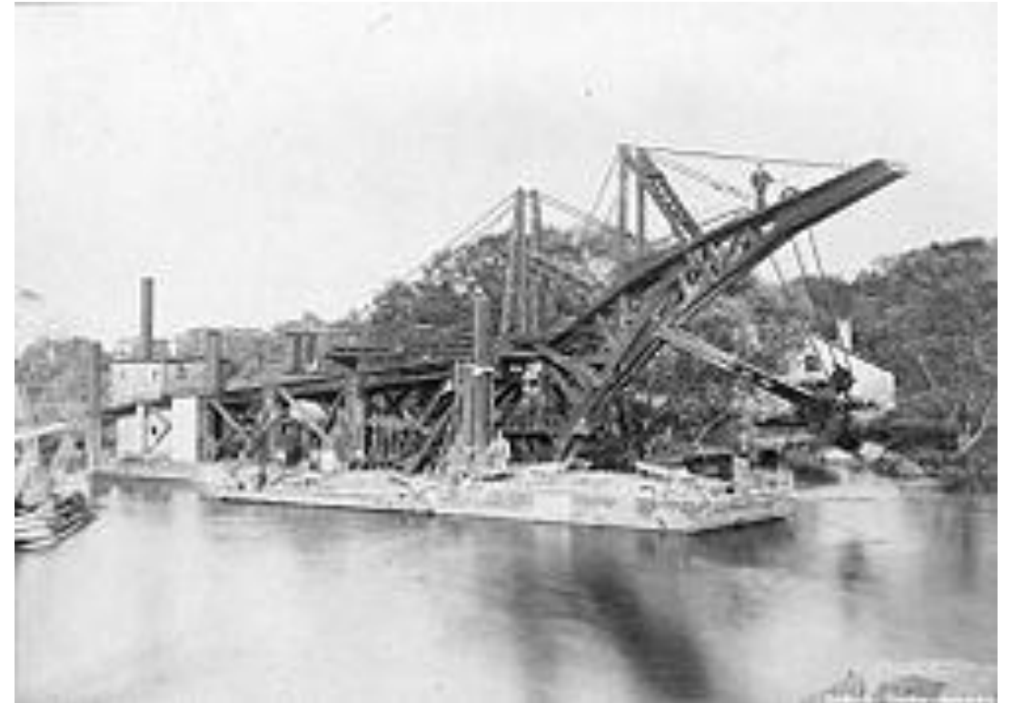
1878-1887 sänktes Hjälmarén med 1,3 m. Mudderverket Enhörningen användes vid sjösänkningen
