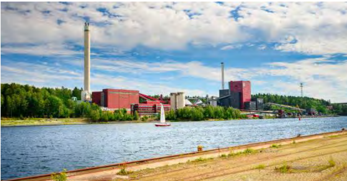
Figur 7.30 Fotografi på befintlig anläggning (Liljewall, 2024).
